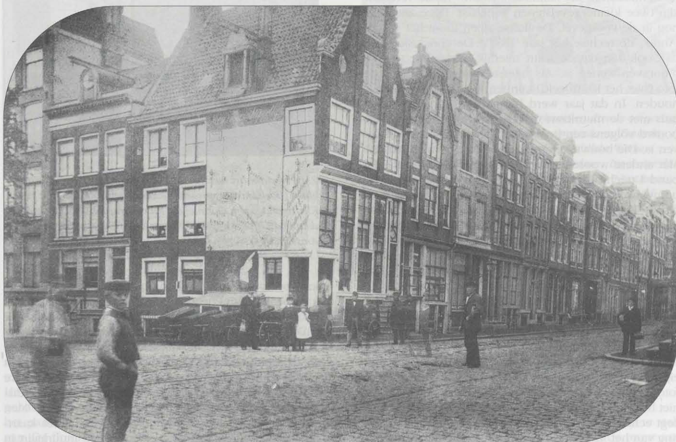
1. Foto van het pand op de hoek van de Utrechtsestraat (nr. 61) en de Keizersgracht waarop de muurkaart aangebracht is / foto-graaf onbekend. - [met zekerheid vervaardigd tussen 1882 en 1887, waarschijnlijk in 1885] (foto in particulier bezit).
